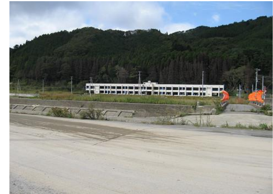
同じ地区の小学校。窓は全て抜けて側だけ残っている感じです。
