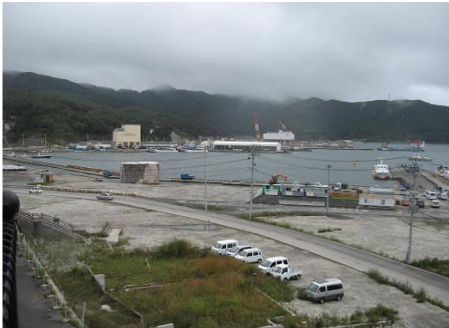
転倒したビルの左側です。
